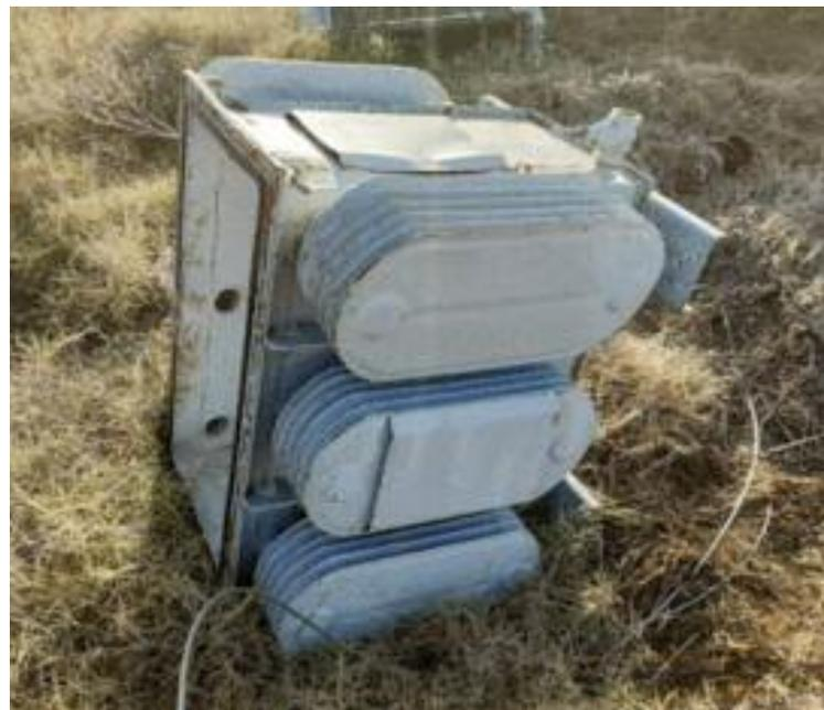
dor usado marca TUBOS TRANS ELECTRIC, N° de EPEC D08201, Potencia 100KVA, tensión 13.200/400-231V, N° de Fabrica 35695, le sustraen la bobina interna, la cual tiene un importante valor dolar.
