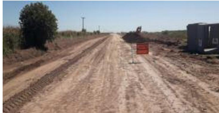
procederá al tratamiento del suelo con maquinaria vial pesada que permita un significativa compactación, para luego dar paso a la parte final con la colocación del ripio.
