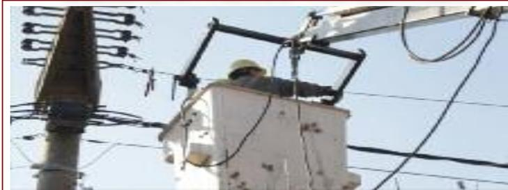
La EPEC con el apoyo de la Cooperativa Eléctrica llevaron a cabo el cambio del cable conductor de energía eléctrica que une la localidad con la estación de rebaje ubicada entre Posse y General Ordóñez.
