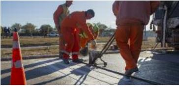
y "Camino Real" (frente a barrios Campos del Oeste y Altos del Molino), se procede, se realizará una demarcación lineal para delimitar los sentidos de circulación y espacios de estacionamiento con spray de 1.5 mm.
