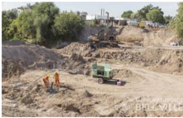
Sobre el camino trabajan las máquinas de la misma empresa, mientras que el municipio adquirió el descarte de cantera o piedra partida usada para la consolidación de la base y 17 tubos para las alcantarillas. Una vez habilitado el camino y el puente, se eliminará el tránsito pesado que circula
