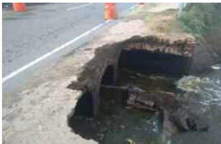
preparó en forma adecuada para mejorar el escurrimiento del líquido. Dadas estas condiciones, el agua comenzó a socavar la tierra y luego siguió con la estructura de los tubos.
